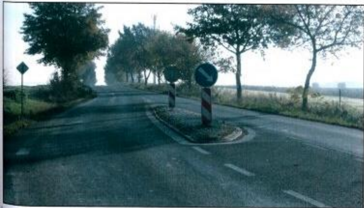
PŘÍKLAD POJÍZDĚNÉHO ZPOMALOVACÍHO DĚLÍČÍHO OSTRŮVKU
