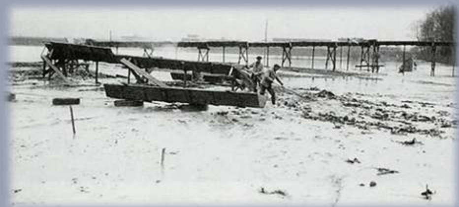
Naplavování zeminy do prostoru Bahňáku
