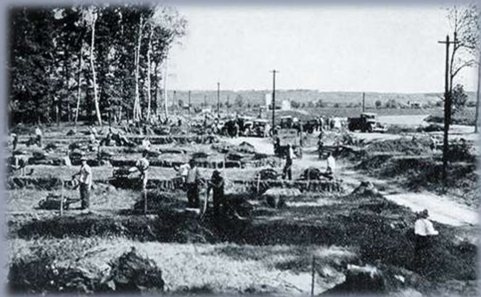
Výstavba Baťova – příprava terénu
