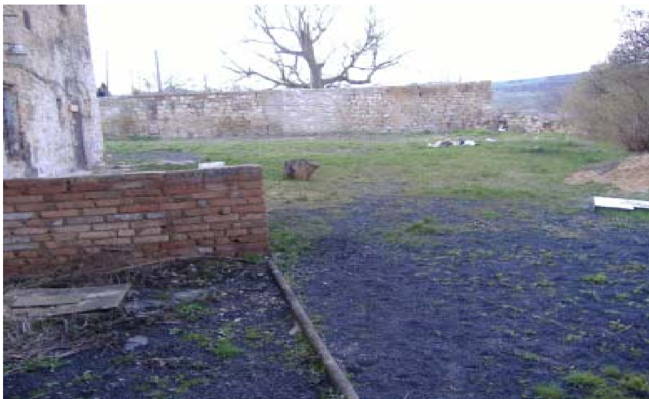
Dvůr před rekonstrukcí - foto:
