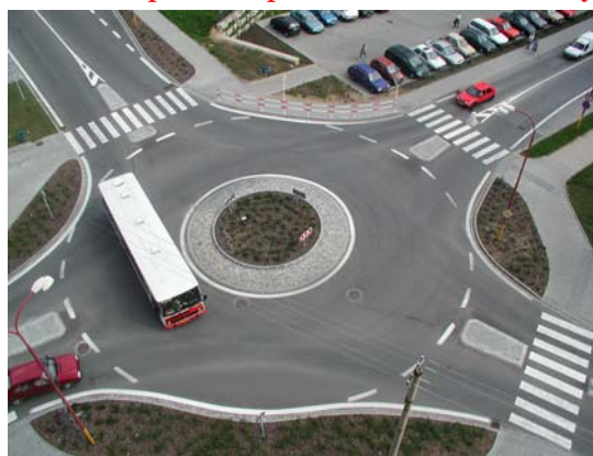
Obr. 8 – Špatná dispozice okružní křižovatky
