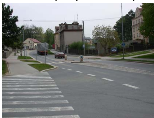
Obr. 6 – Úprava průtahu (Dobřany)
